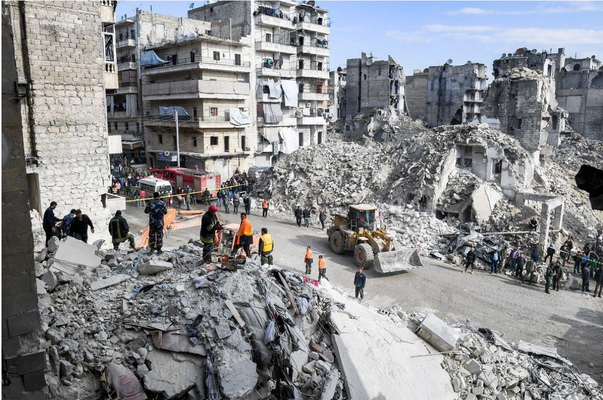
Syrische Zivilschutz Helfer durchsuchen am 2. Februar 2019 die Trümmer eines am 2. Februar 2019 eingestürzten fünfstöckigen Gebäudes im Stadtteil Salah al-Din im Norden der Stadt Aleppo | Foto: George OURFALIAN / AFP
